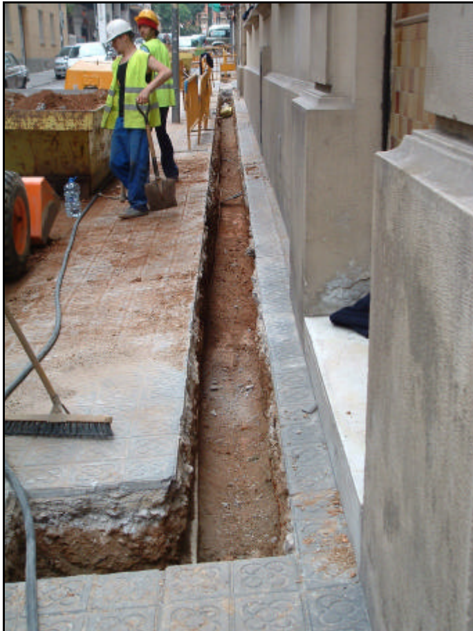
Fotografia 5. Detall rasa 1 al carrer Plató, 5-11, un cop realitzat el buidatge de terres a 70 cms.
