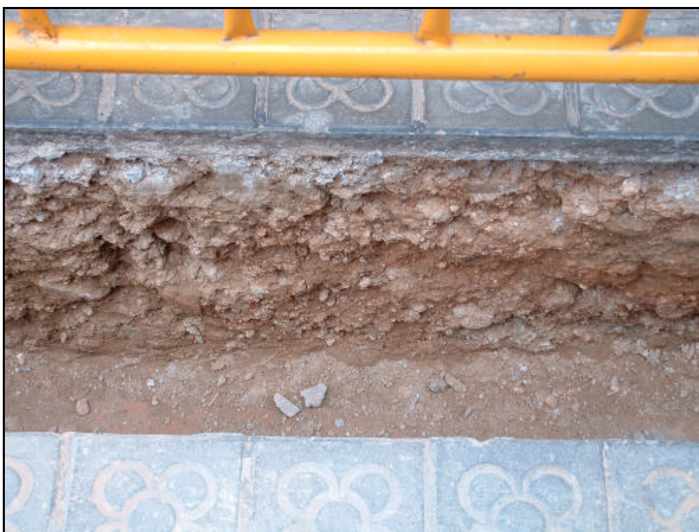
Fotografia 7. Detall nivell d'aportació U.E. 04, localitzat a lo llarg de la rasa 1, corresponent al rebliment de la rasa del servei de la llum U.E. 05.
