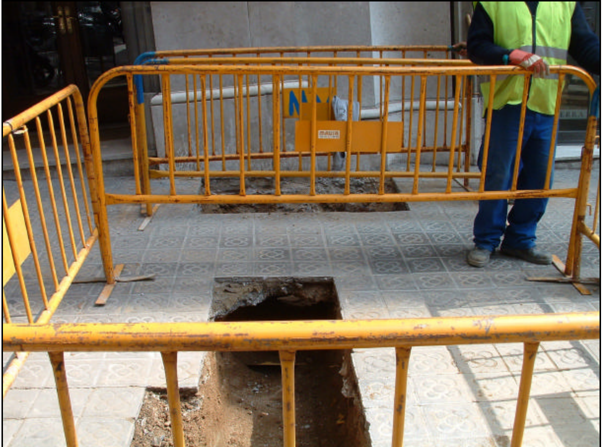
Fotografia 11. Detall cales realitzades al carrer Muntaner, 402.
