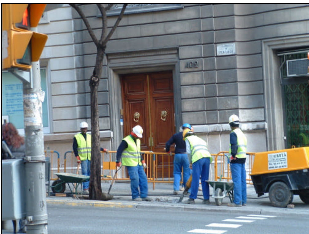
Fotografia 4. Detall obrers realitzant tasques obertura carrer Muntaner, 402.
