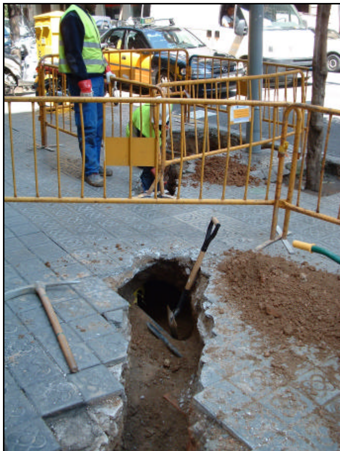
Fotografia 9. Detall obertura cala al carrer Muntaner, 407.
