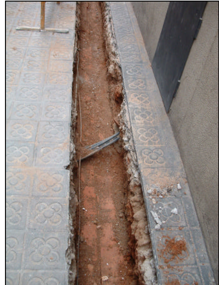
Fotografia 6. Detall servei de la llum localitzat a lo llarg de la rasa 1, a 70 cms. de potència respecte el nivell de carrer actual.
