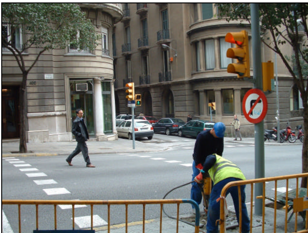
Fotografia 3. Detall obrers realitzant tasques obertura carrer Muntaner, 407.
