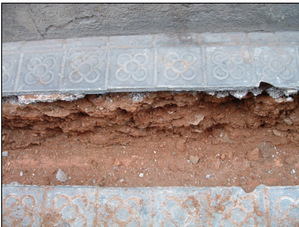
Fotografia 8. Detall nivell d'aportació U.E. 04, localitzat a lo llarg de la rasa 1, corresponent al rebliment de la rasa del servei de la llum U.E. 05.
