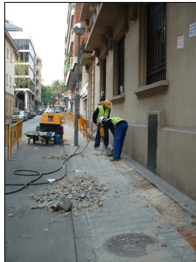
Fotografia 2. Detall obrers realitzant tasques obertura carrer Plató, 5-11.
